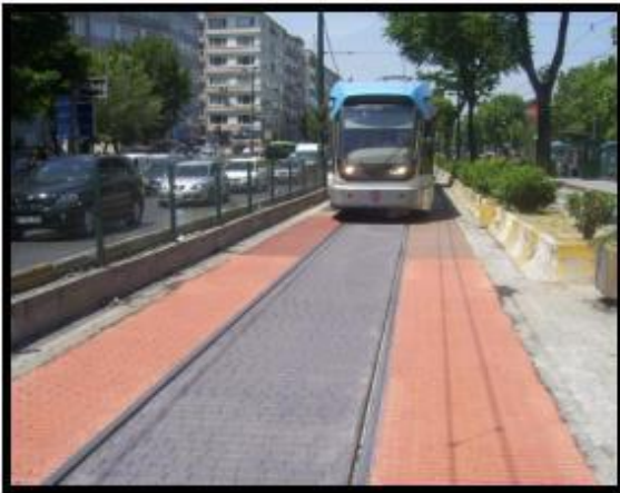
Resim 1. Oluklu Ray Tipi (Grooved) Hattı (RI-60)
