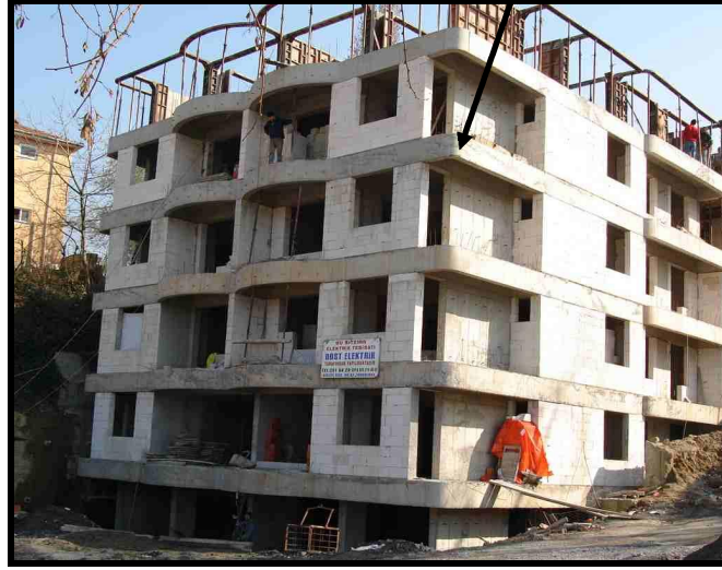
Şekil 6: Eski üretim alanlarında aşırı harcamalarla yapılan konut inşaatı
