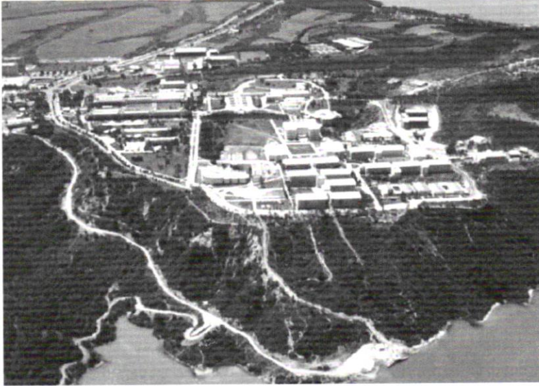
Şekil-1. Ç.Ü.Kampus alanının kuzeyden çekilmiş görüntüsü
