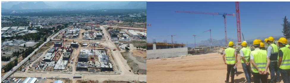
Resim 7 : Şantiye Alanı ve Teknik Gezi.
