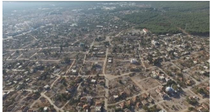
Resim 4 : Alanın Tahliyesi ve Yıkım Çalışmaları
