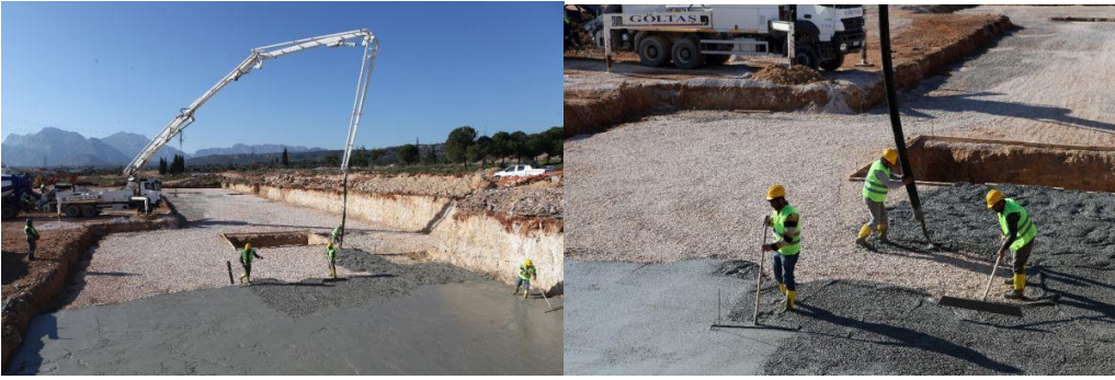
Resim 6 : 1. Etap Temel Atılması.
