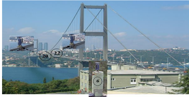
Şekil 5: 6 numaralı referans noktasından 20 ve 22 numaralı obje noktalarının GPS ile ölçülmesi
