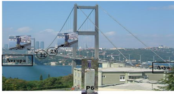
Şekil 1: Boğaziçi Köprüsü, referans noktası (P6) ve obje noktaları (22-23)
